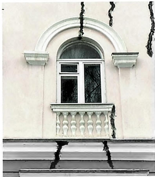
Оконный проем лестничной клетки с архивольтом
