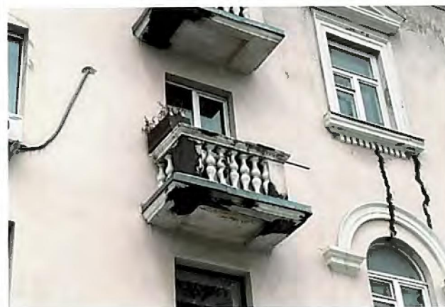
Открытый балкон с балюстрадным ограждением
