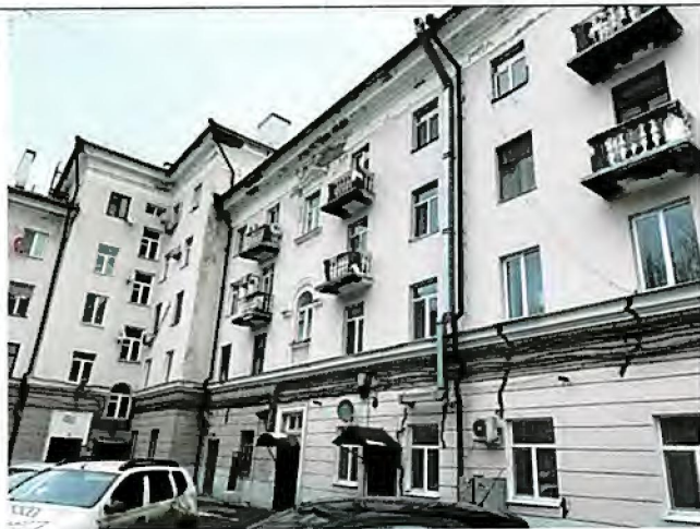
Вид на западный фасад
