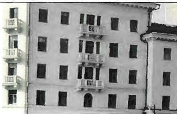
Историческое столярное заполнение окон
