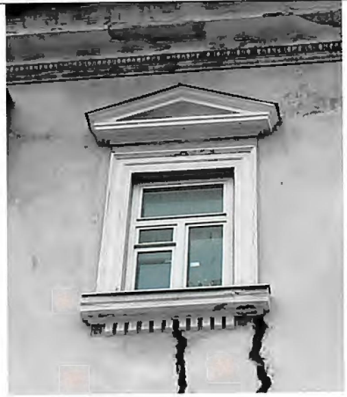
Оконный проем лестничной клетки с треугольным фронтонным тимпаном
