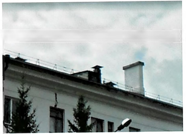
Слуховые окна и печные трубы
