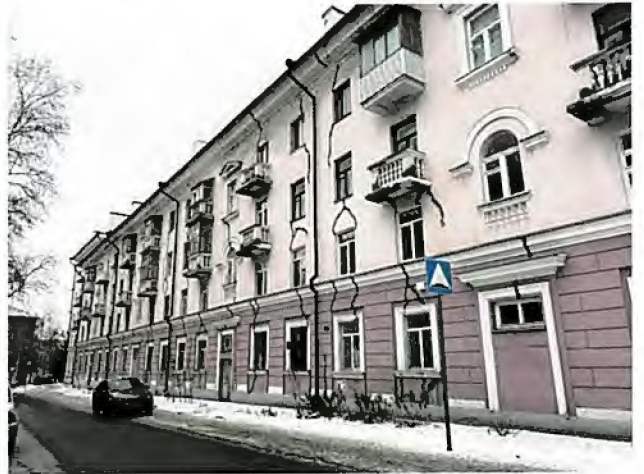
Вид на северный фасад
