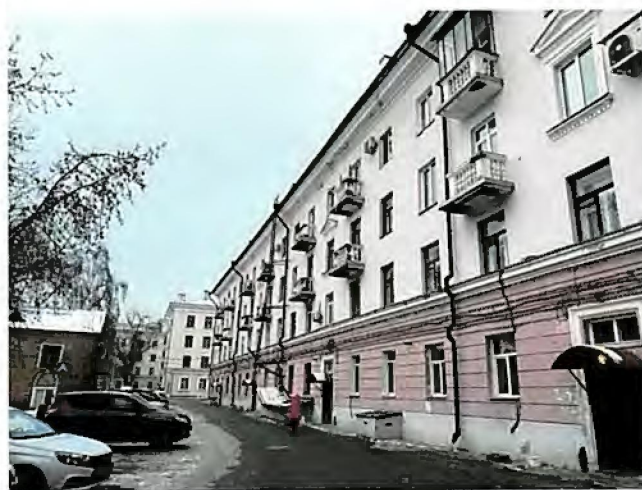
Вид на южный фасад
