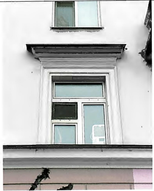
Оконные проемы второго этажа с карнизом
