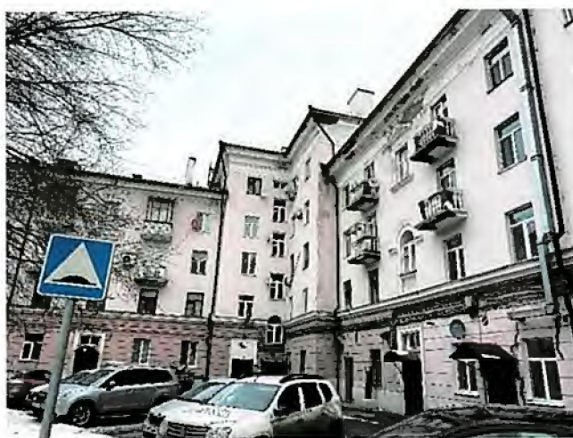
Вид на угол здания со двор
