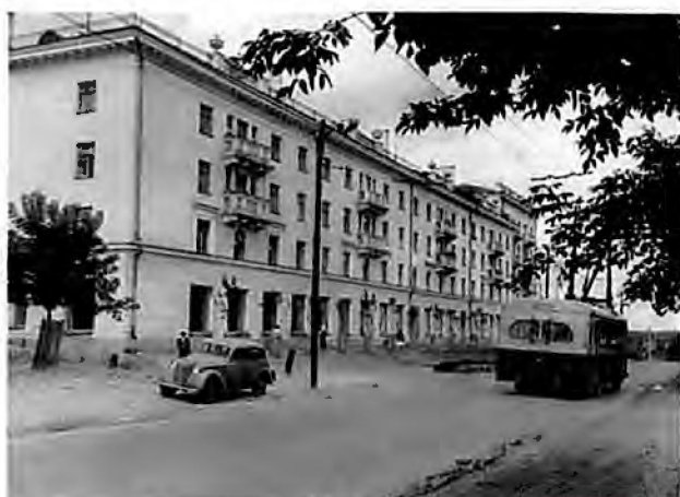
Вид на дом № 11/10 с ул. Степана Халтурина (фото 1953 г.)
