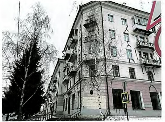
Вид на угол здания
