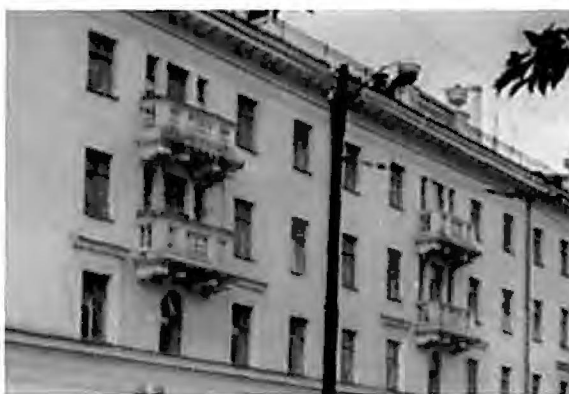
Балкон с кронштейнами и балюстрадным ограждением
