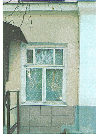
Историческая расстекловка окон первого этажа
