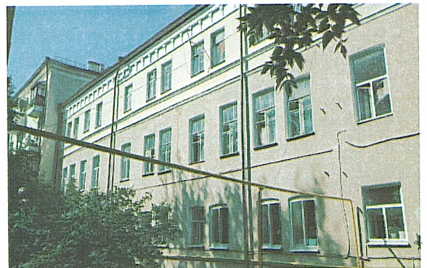
Фрагмент дворового фасада
